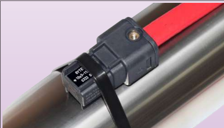
电缆插入拧紧并安装在管道上
